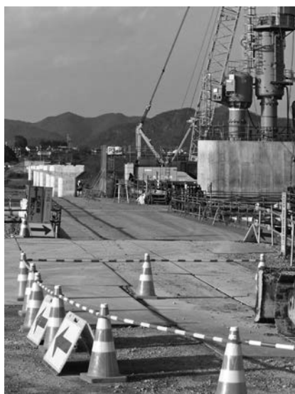
((仮称)新愛岐大橋建設風景)
