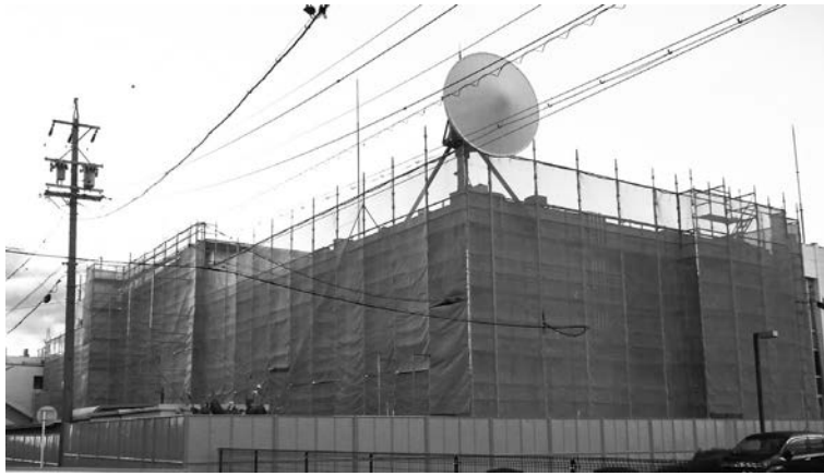
(工事中の役場庁舎)
