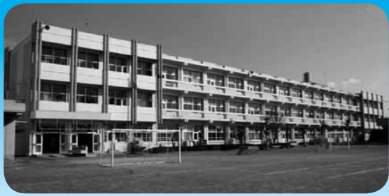
空調設備工事を行う山名小学校校舎
