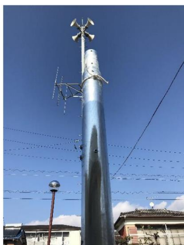
写真4 柏森南保育園 建柱第1節工事 後ろはアナログ拡声子局
