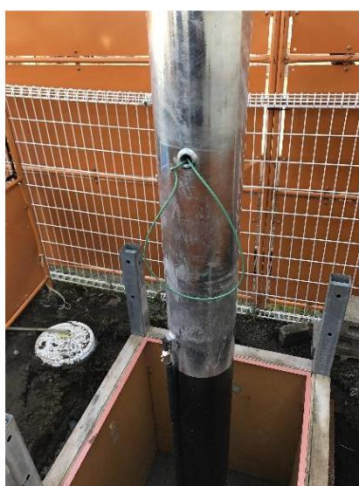
写真5 柏森南保育園 建柱型枠工事
