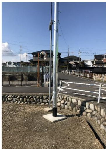
写真1 中央公民館駐車場 屋外拡声子局の建柱工事
