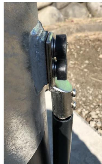
写真3 中央公民館駐車場 避雷接続端子工事
