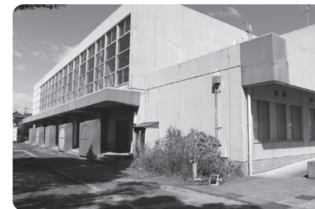
校舎トイレ及び体育館の大規模改修を予定している高雄小学校
