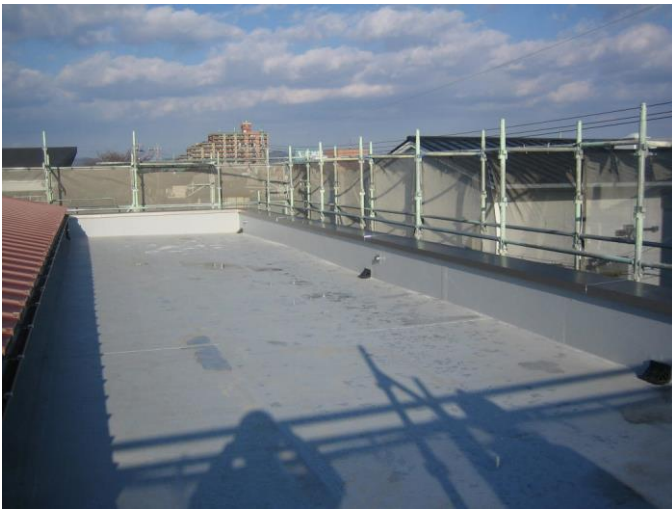
屋上陸屋根の塩化ビニルシート防水状況
