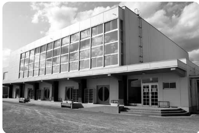
LPガスを燃料とするエアコン設置工事を実施する4小学校体育館
