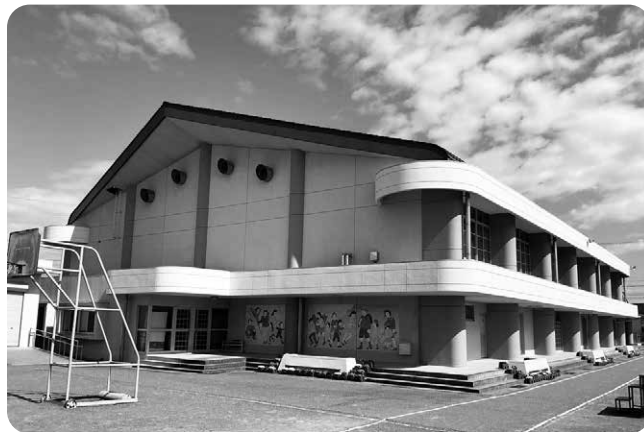
柏森小学校体育館の和室を改修し、児童クラブ室を増設する
