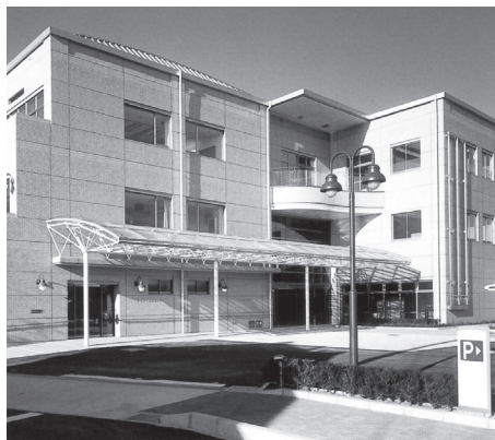
< 扶桑町総合福祉センター 外観 >
