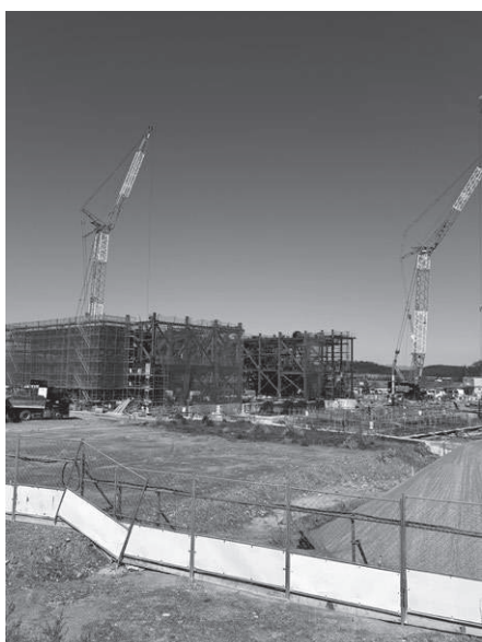
(建設が進む新ごみ処理施設)
