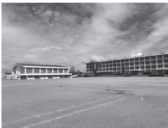
(避難所に指定された扶桑北中学校)
