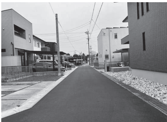
(側溝新設及び舗装修繕工事後の状況)
