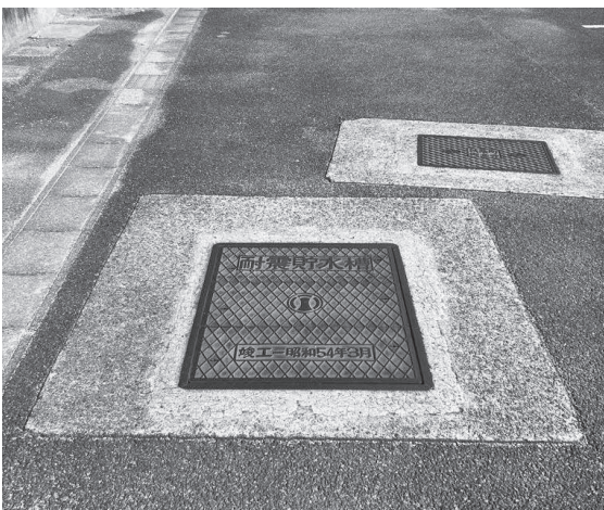
(役場内の耐震貯水槽の点検口)
