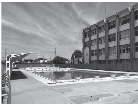
(扶桑東小学校のプールの状況)
