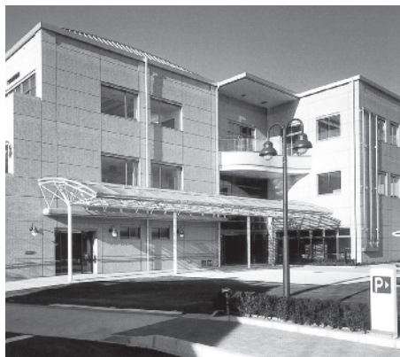
< 扶桑町総合福祉センター 外観 >
