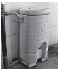
雨水利用貯留施設 (200ℓ)
