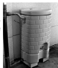
雨水利用貯留施設 (200ℓ)
