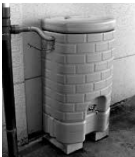
雨水利用貯留施設 (200ℓ)
