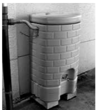
雨水利用貯留施設 (200ℓ)
