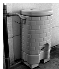
雨水利用貯留施設 (200ℓ)
