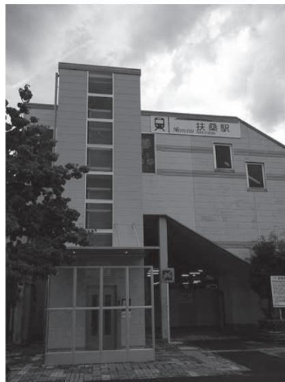
名鉄扶桑駅のエレベーター
