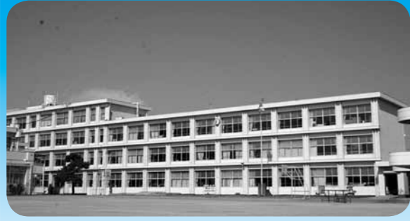
エアコン設置工事を行う柏森小学校校舎
