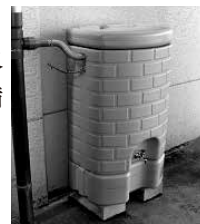
雨水利用貯留施設 (200ℓ)
