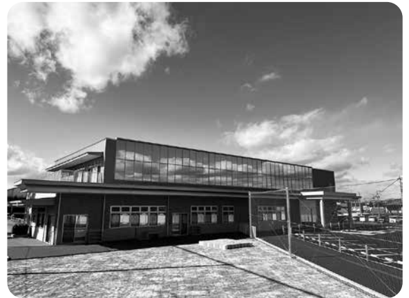
令和5年4月に開館した扶桑町児童センターひまわり
