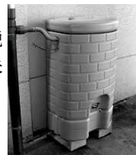
雨水利用貯留施設 (200ℓ)
