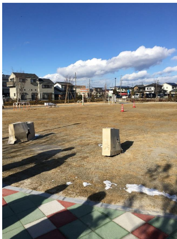
写真 4.5 遊具設置養生状況
