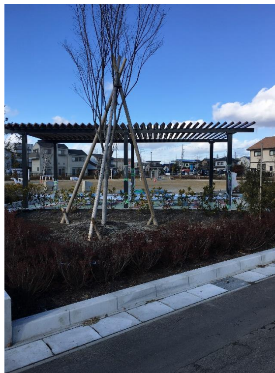
写真 4.6 パーゴラ設置状況
