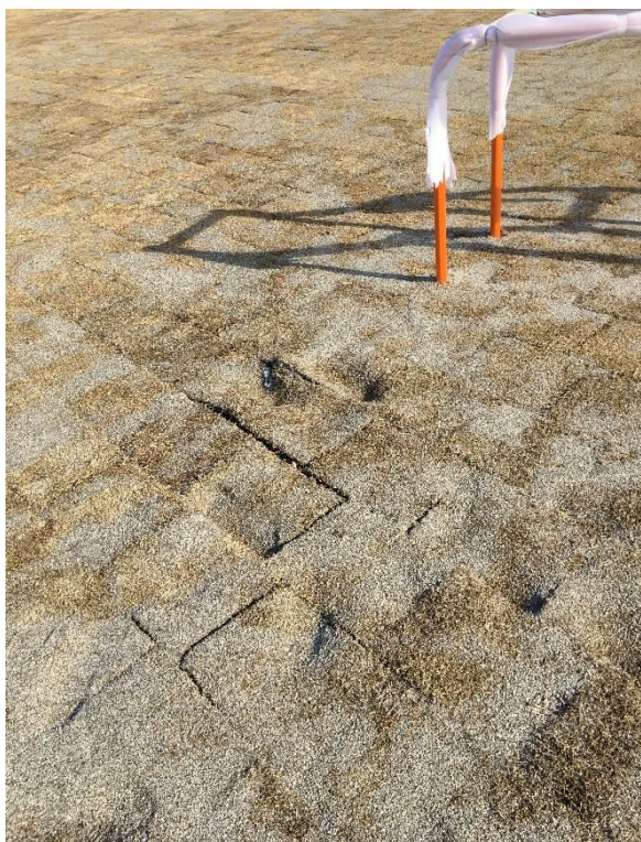
写真 4.1 芝生床土不良箇所 1
