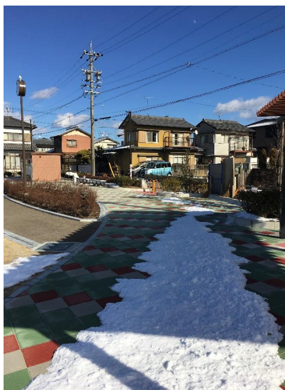
写真 4.4 出入口、植栽、園路施工状
