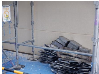
塗装材料使用済み保管 (使用量検収用)
