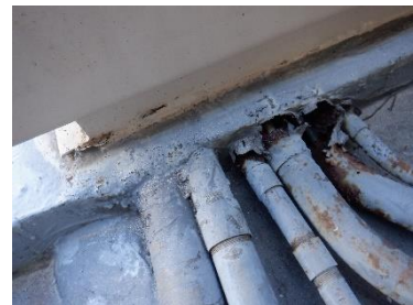
PH 屋上 機器基礎廻り
