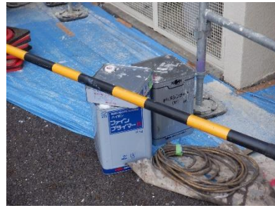
塗装材料仮置き (監査日使用材料) 料
