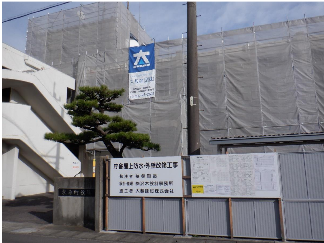
南面写真 (一部)
