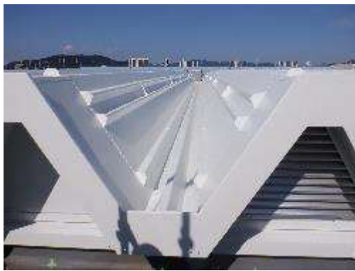
写真-2 体育館屋根 遮熱塗料施工済み
