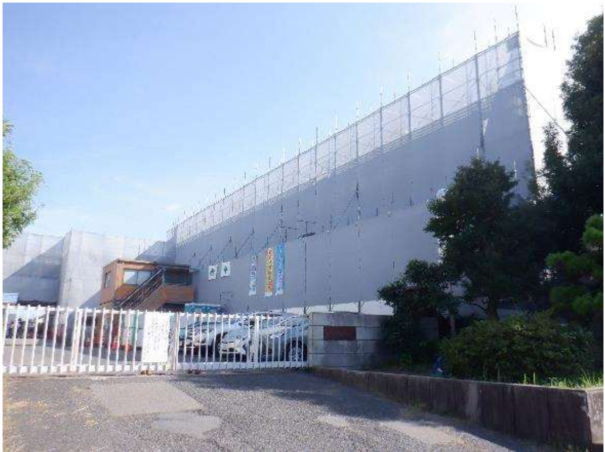
写真-1 全景写真 (10月1日)
