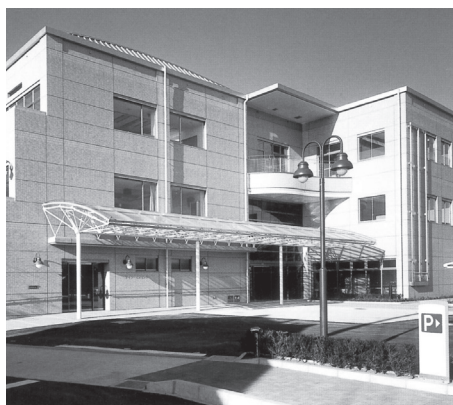
< 扶桑町総合福祉センター 外観 >
