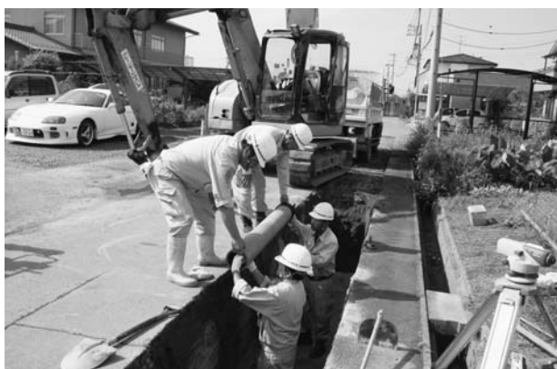
下水道管埋設工事
