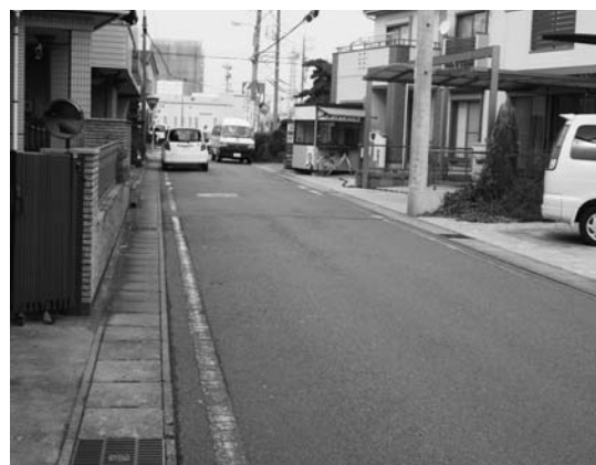
江南厚生病院東側道路
