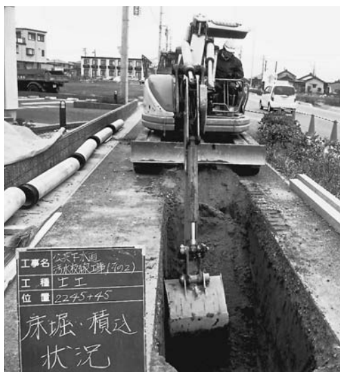
下水道工事（高木地内）
