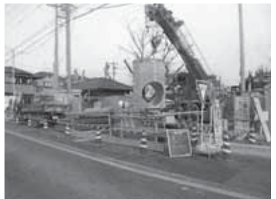
下水道工事の様子
