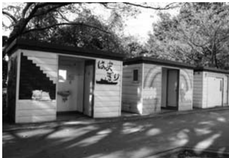
現在の緑地公園水洗トイレ
