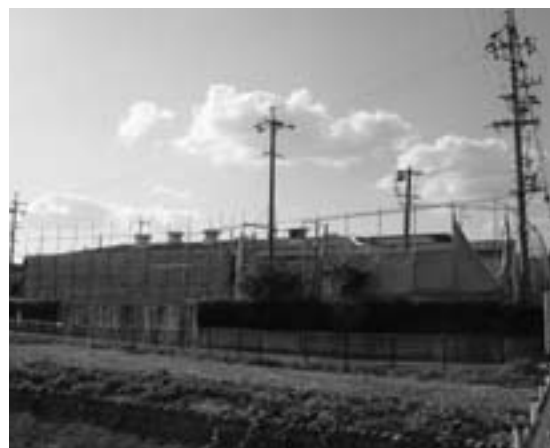
取り壊しが行われている旧学校給食共同調理場
