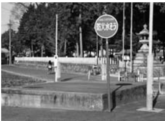
防火水槽（南山名神地地内）
