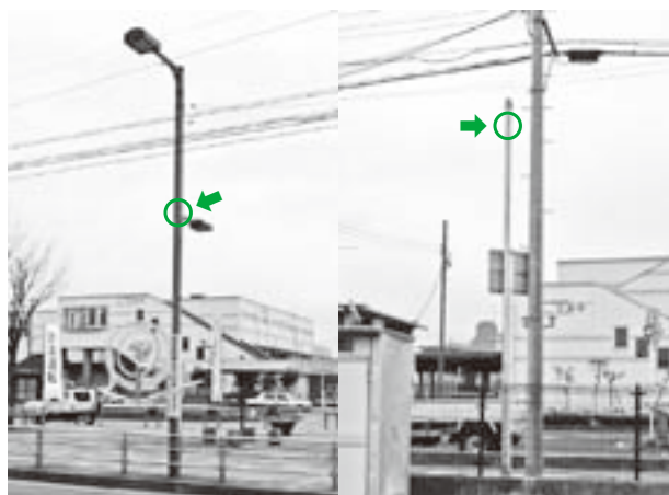
防犯カメラが設置される扶桑駅 左：西ロータリー 右：東ロータリー
