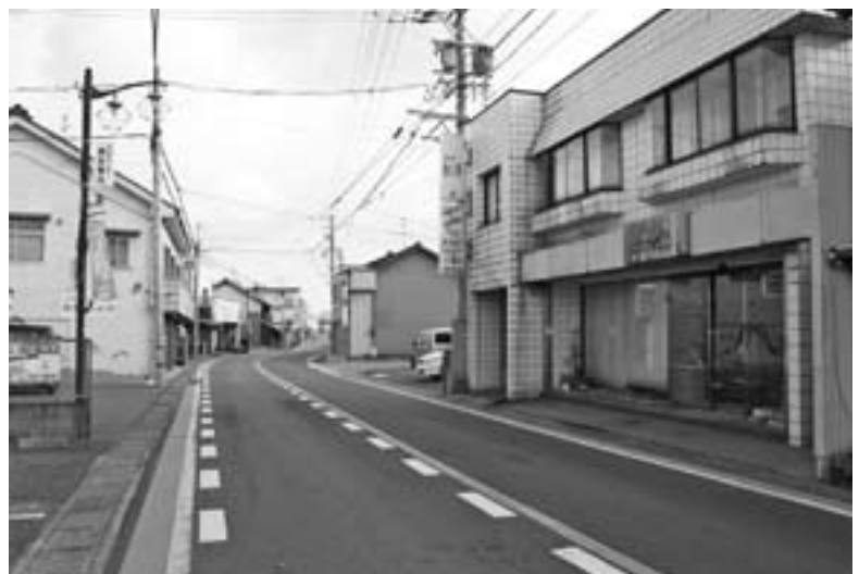
県道外坪扶桑線（柏森地内）
