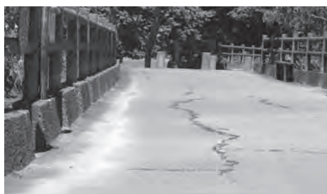
舗装修繕をするサイクリングロード
