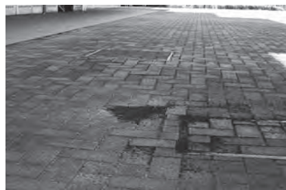
修繕をする文化会館前広場
