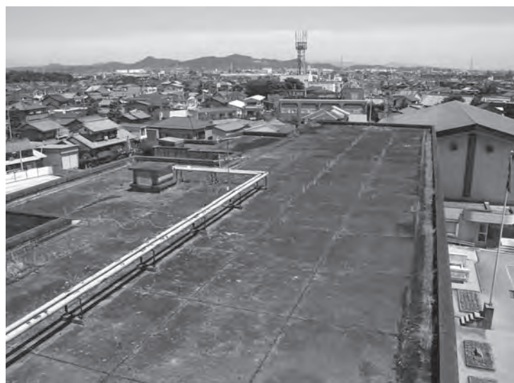
防水改修工事をする柏森小学校屋上
