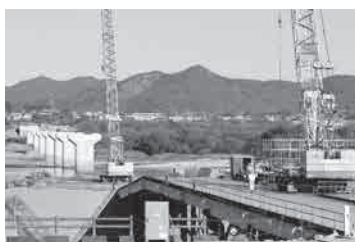
(工事中の(仮称)新愛岐大橋)
