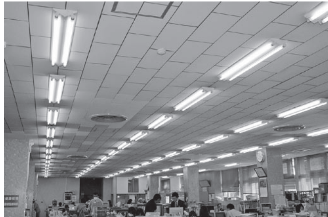
役場庁舎内の蛍光灯をLEDに取替え
