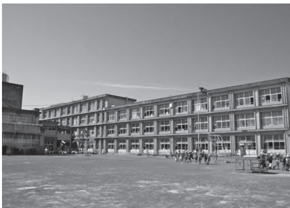
大規模改修工事が行われる柏森小学校
