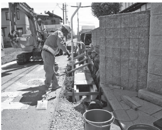
側溝整備の様子（南山名地内）
