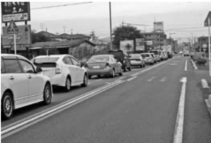
押しボタン信号設置が望まれる県道愛岐線の高木吉山交差点西側
