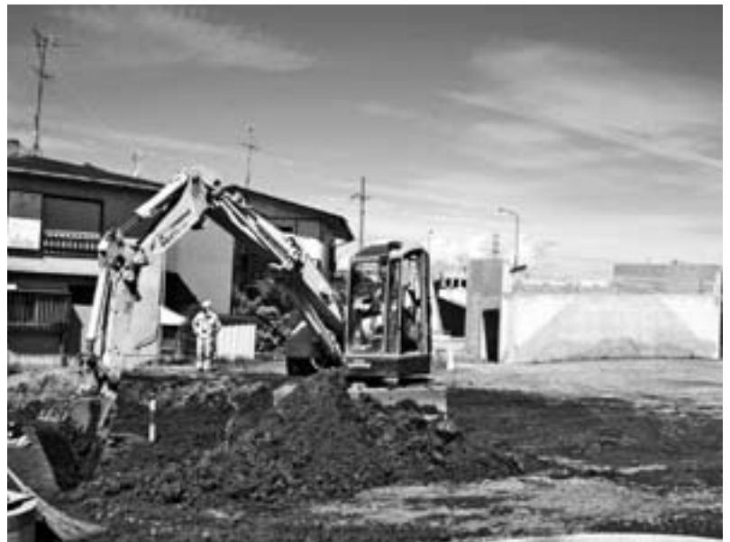
建設中の町道犬山富士線
