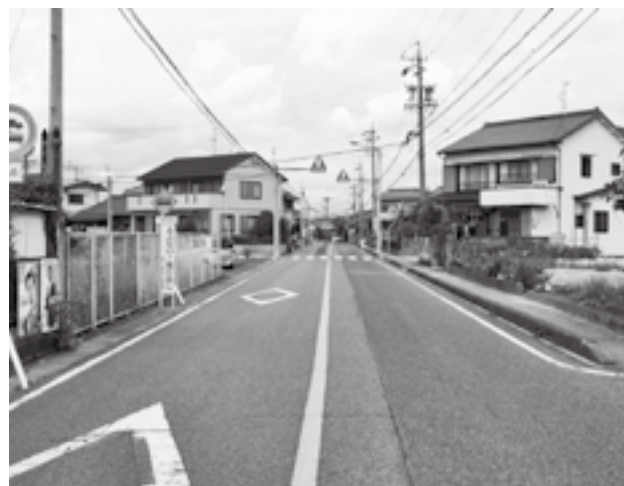
下水道工事箇所（柏森字平塚地内）
