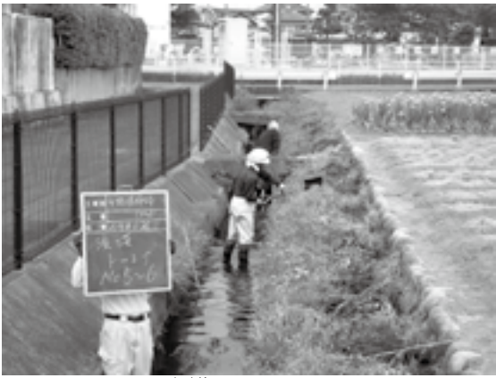
丹羽用水 しゅんせつ 浚渫（高雄字福塚地内）
