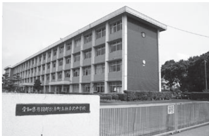
大規模改修工事が行われる扶桑北中学校 （外壁・屋上・建具・教室・トイレ等の改修）
