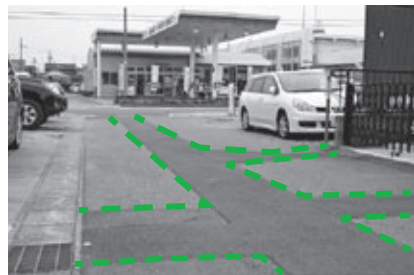
仮復旧の道路
