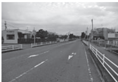
町道高雄・橋爪線 工事予定箇所
