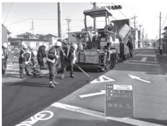
入札による工事（町道舗装修繕工事）
