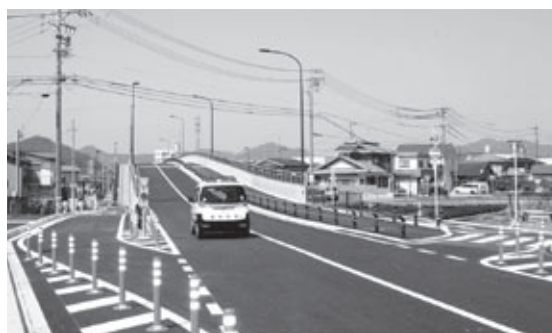
高雄地内から上野跨線橋・犬山市方面を臨む
