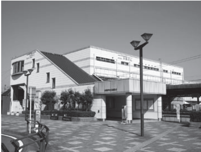
エレベーター設置工事等が予定される扶桑駅
