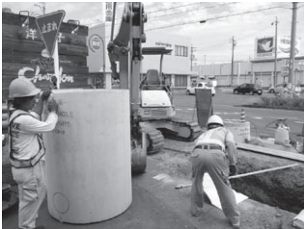
下水道工事 (県道一宮犬山線)
