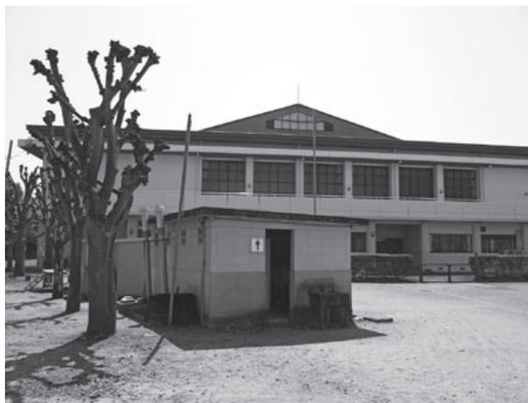
総合グラウンドの屋外トイレ（汲み取り式）
