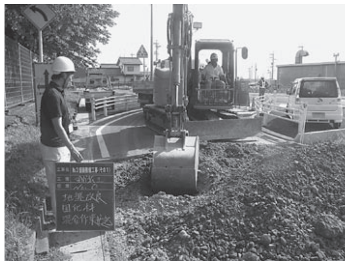
舗装整備工事
