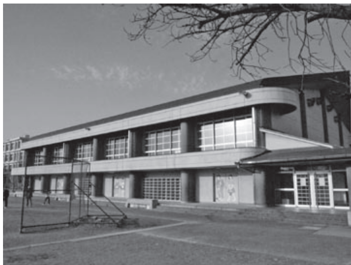
柏森小学校体育館 (外壁・吊り天井の撤去・照明器具等の改修を予定)
