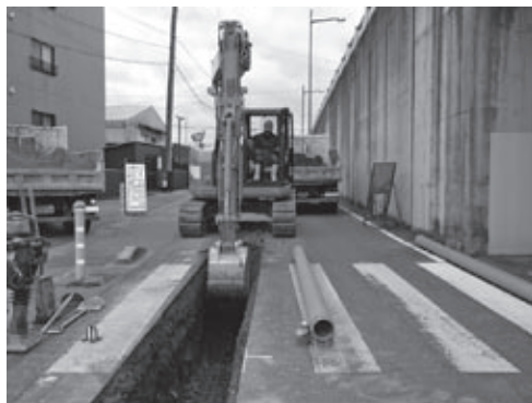
高雄字犬堀地内の下水道工事
