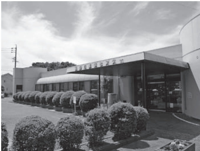
竣工後35年経過の保健センター
