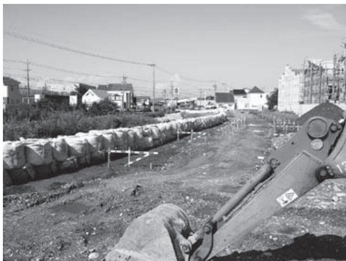
早急な治水対策が強く求められている 一級河川青木川の改修事業
