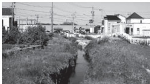
下流部から交差する橋梁部を臨む
