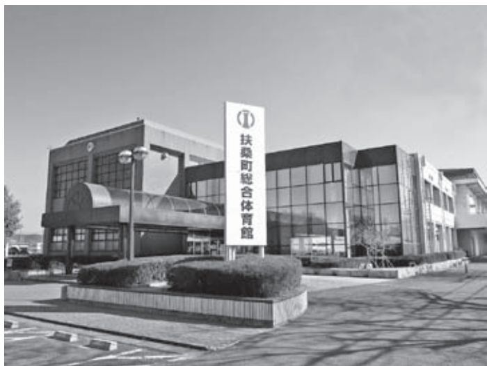
公共施設（建物）の大半は、昭和が建設年 扶桑町総合体育館（建設年 昭和57年）
