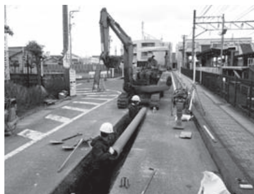
高雄字下山地内の下水道工事
