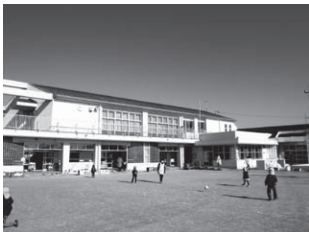
大規模改修工事が行われる柏森南保育園
