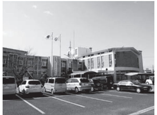
扶桑町公共施設等総合管理計画の対象となる 扶桑町役場（建設年 昭和42年）
