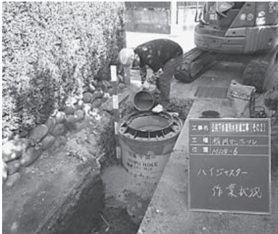
下水道整備工事
