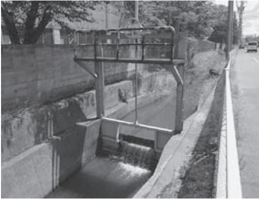
改修事業が予定される村田排水路
