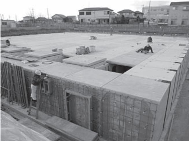
柏森長畑公園（平成29年度完成予定）の下に、雨水対策として、約1,500㎡の貯留施設を設置（平成28年3月工事完了）
