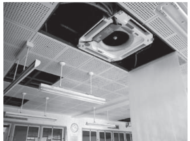
天井にエアコン室内機の取り付けが施工される 山名小学校の教室（平成28年12月撮影）
