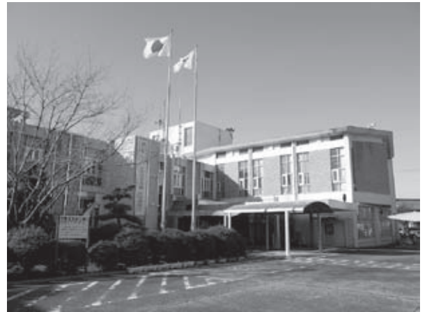
役場が被災した場合の対応は （扶桑町役場）
