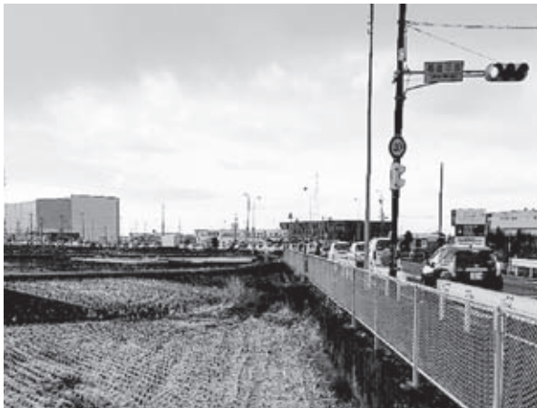
早朝から混み合う国道41号線への町道 (高雄字中郷交差点)
