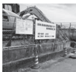
工事が始まった (高雄放課後児童クラブ専用棟)
