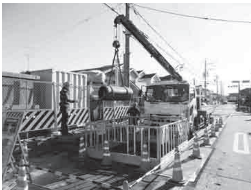
公共下水道工事（扶桑町大字高雄地内）
