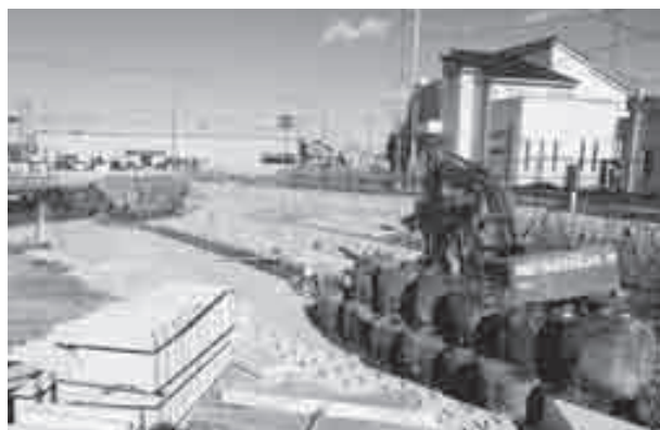
青木川の護岸工事（斎藤地内）
