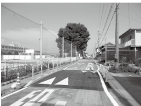
山名地区での仮設ハンプ実証実験
