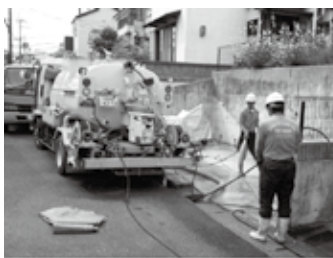
きかいしゆんせつ 機械浚渫（側溝） 高压洗浄車と強力吸引車を使って側溝に溜まる土砂などを除去する作業のこと
