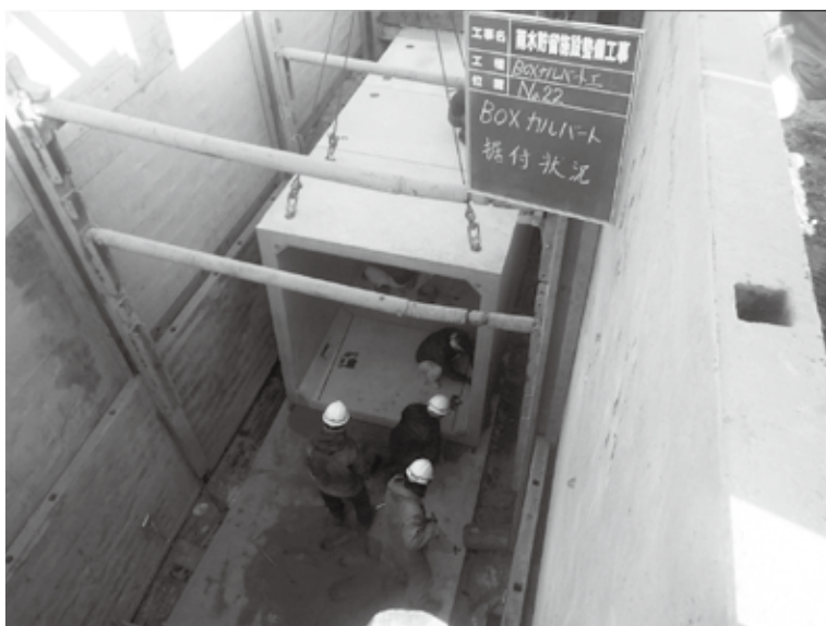
雨水貯留施設（斎藤字座敷野）
